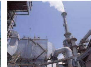
6 電気集塵機・排煙脱硫装置
